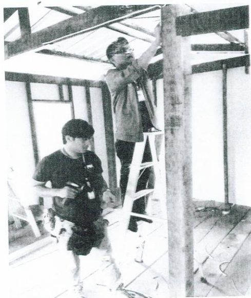
พนักงานการไฟฟ้าส่วนภูมิภาคสาขาอำเภอบางคนที ร่วมมือติดตั้งอุปกรณ์ไฟฟ้า
