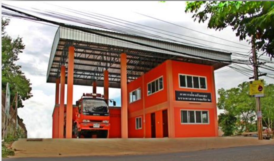
ก่อสร้างโรงเรียนเทศบาลเสาธงหิน ศูนย์พัฒนาเด็กเล็กเทศบาลเสาธงหิน ๒ ก่อสร้างอาคารป้องกันและบรรเทาสาธารณภัย แห่งที่ ๒
