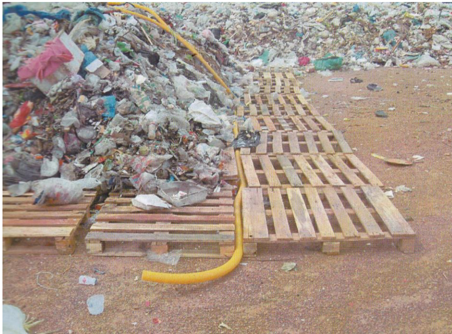
วางท่อระบายอากาศระยะห่างของท่อ 4-5 เมตร
