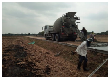
รูประหว่างดำเนินงาน
