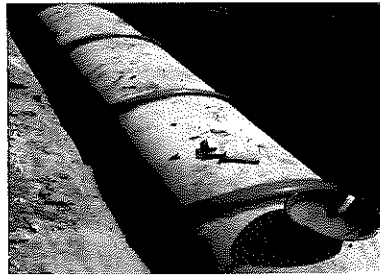
รูประหว่างดำเนินงาน
