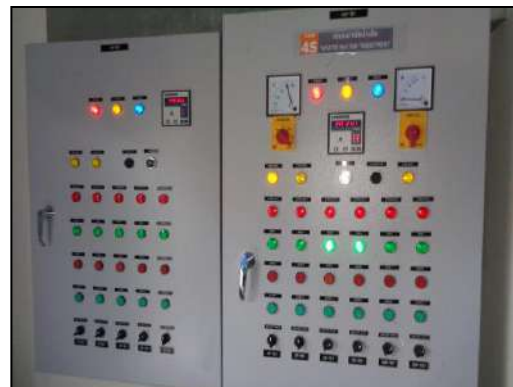
ตู้ไฟฟ้าแสดงการทำงานของระบบบำบัดน้ำเสีย
