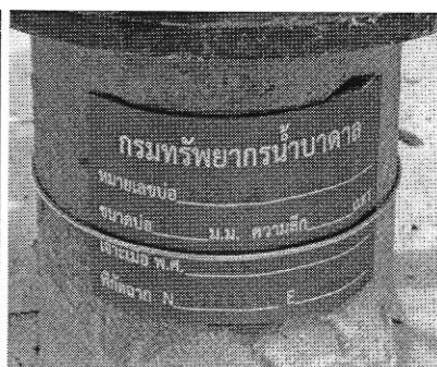
ป้ายแสดงรายละเอียดบ่อน้ำบาดาล
