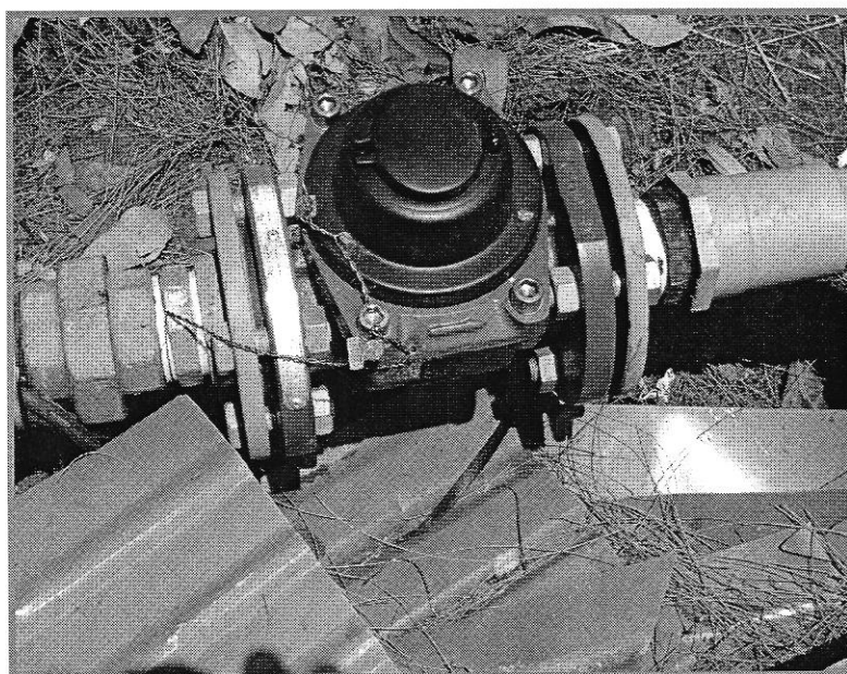
ภาพ ๑๘ แสดงการร้อยลวดบนท่อดูดน้ำบาดาลกับเครื่องวัดปริมาณน้ำบาดาล
