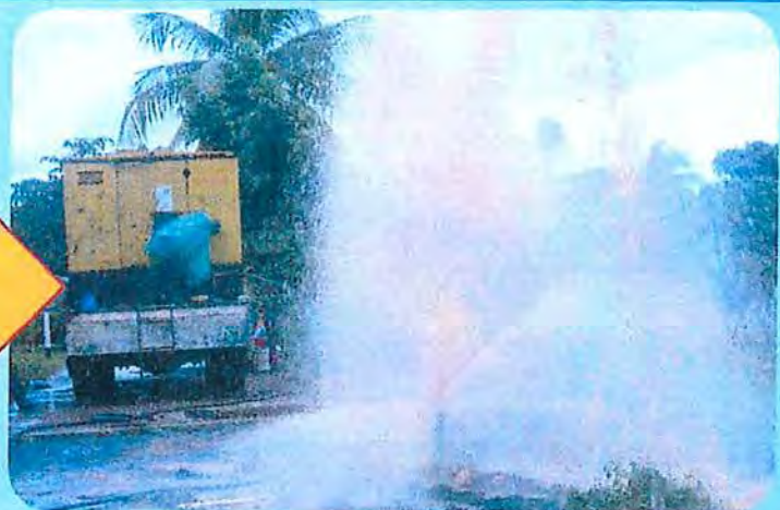
เครื่องอัดอากาศใหม่
