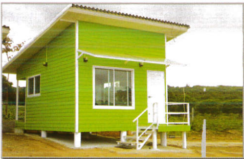
บ้านประกอบเสร็จ
