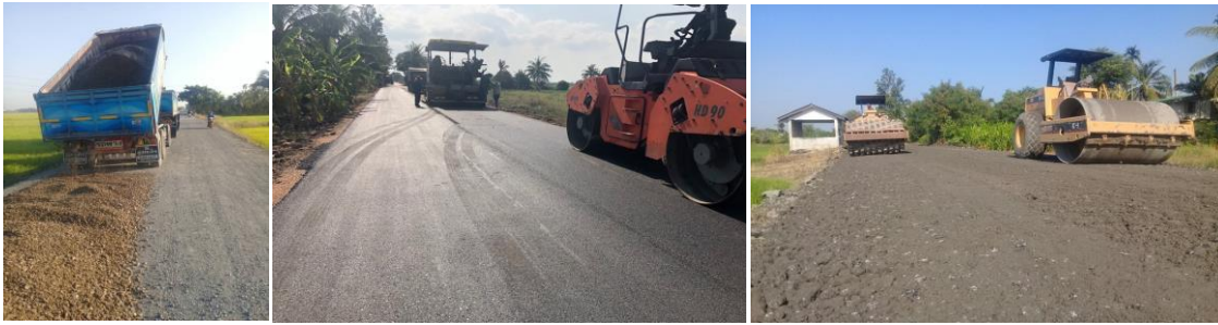
๕. ซ่อมแซมปรับปรุงผิวจราจร ม.๑๕
