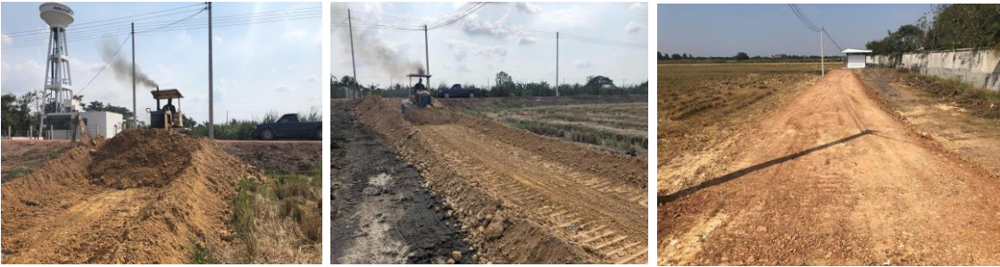
๑๑. ติดตั้งป้ายไฟกระพริบพลังงานแสงอาทิตย์
