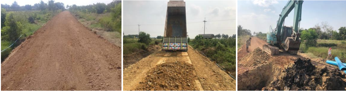
๑๐. ก่อสร้างถนนดิน ม. ๑๑ (ทางเข้าโรงสูบน้ำประปา)
