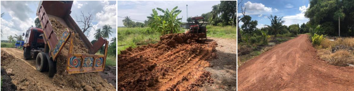
๒๑. ก่อสร้างถนนคอนกรีตให้เป็นผิวจราจรลาดยาง ม.๑๖
