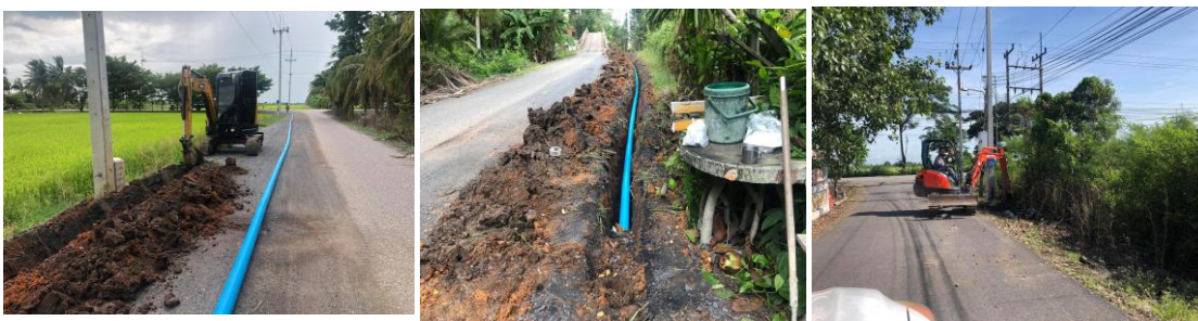
๒๖. ปรับปรุงซ่อมแซมถนนผิวจราจรลาดยาง ม.๑๕-๑๖
