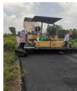
๑๘. ก่อสร้างถนนคอนกรีตให้เป็นผิวจราจรแอสฟัลต์ติกคอนกรีต ม.๑๕
