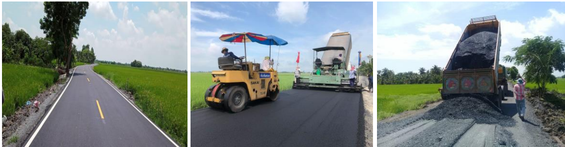
๒๐. ก่อสร้างซ่อมแซมถนนผิวจราจรแอสฟัลต์ติกคอนกรีต หมู่ที่ ๙
