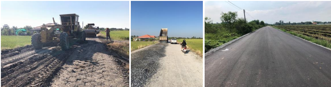
๗. ซ่อมแซมปรับปรุงผิวจราจร ม.๑๔
