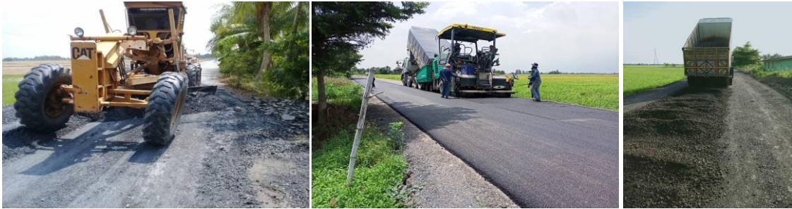
๖. ซ่อมแซมปรับปรุงผิวจราจร ม.๑๒
