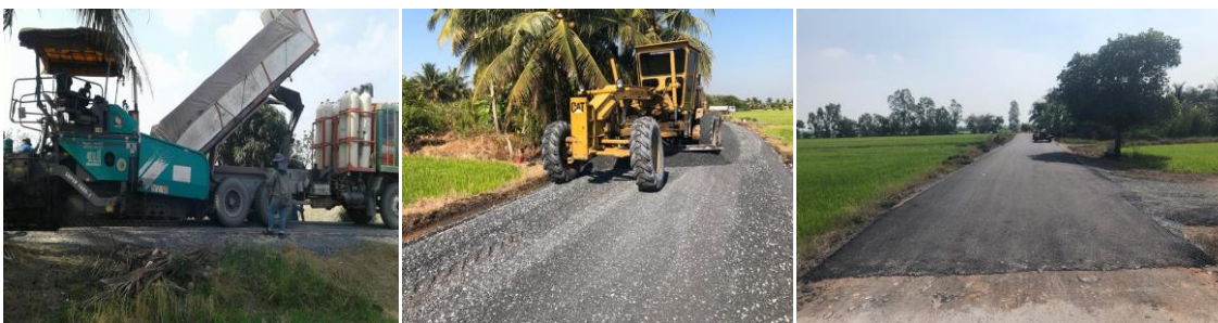
๙. ก่อสร้างถนนดินพร้อมลงลูกรัง ม. ๑๑
