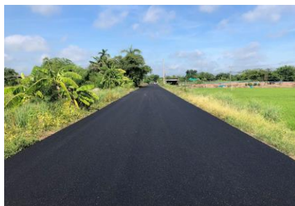
๑๘. ก่อสร้างถนนคอนกรีตให้เป็นผิวจราจรแอสฟัลต์ติกคอนกรีต ม.๑๕
