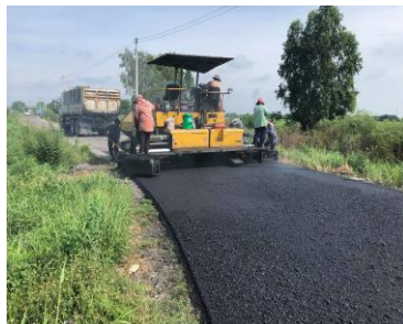
๑๘. ก่อสร้างถนนคอนกรีตให้เป็นผิวจราจรแอสฟัลต์ติกคอนกรีต ม.๑๕
