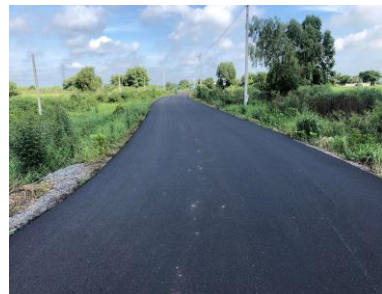
๑๘. ก่อสร้างถนนคอนกรีตให้เป็นผิวจราจรแอสฟัลต์ติกคอนกรีต ม.๑๕
