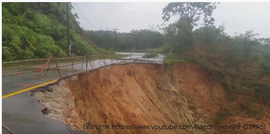
รูปที่ 4-2 เหตุการณ์ดินถล่มบนถนนเส้นทางสายสุคีริน-ยะลา ช่วงกิโลเมตรที่ 4 ทำให้เส้นทางไปสู่อำเภอสรีสาครพังเสียหาย เมื่อเดือนธันวาคม 2557 มีสาเหตุมาจากมีฝนตกหนักอย่างต่อเนื่อง จึงเกิดน้ำท่วมฉับพลัน น้ำป่าไหลหลาก และดินถล่ม
