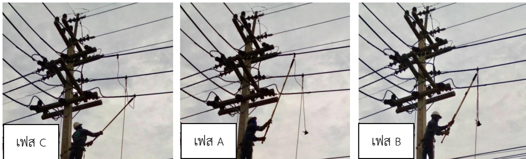
ขั้นตอนการปลดชุดเครื่องมือต่อสายลงดิน (Short Ground) ระบบจำหน่าย 22/33 เควี.
