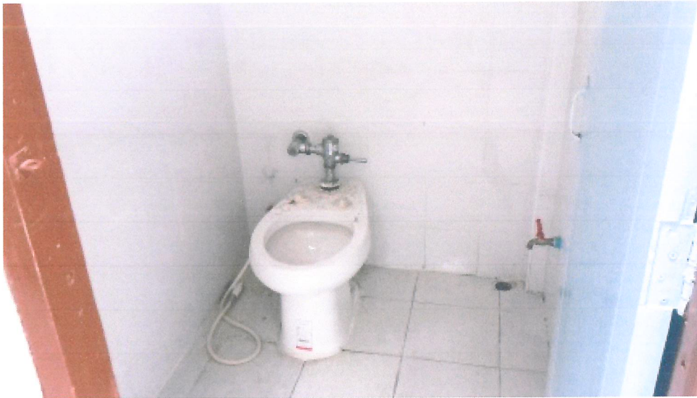
ปรับปรุงห้องนํ้านักเรียน อาคาร 6 จำนวน 2 ห้อง
