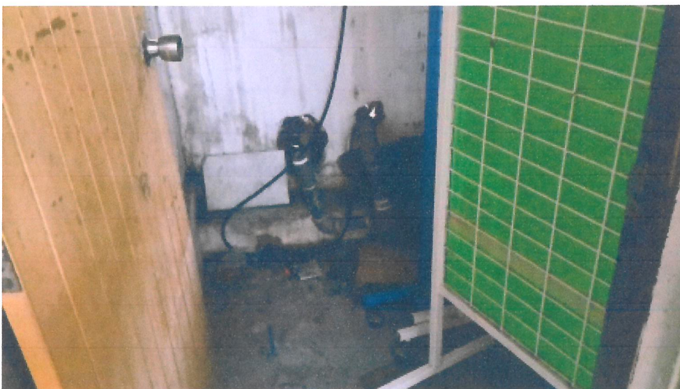
ปรับปรุงห้องน้ำครู ชั้น 1 อาคาร 2 ฝั่งตะวันตก จำนวน 2 ห้อง
