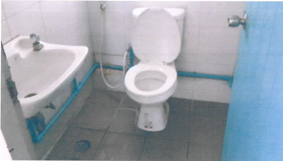
ปรับปรุงห้องน้ำครุ ชั้น 1 อาคาร 6 จำนวน 2 ห้อง
