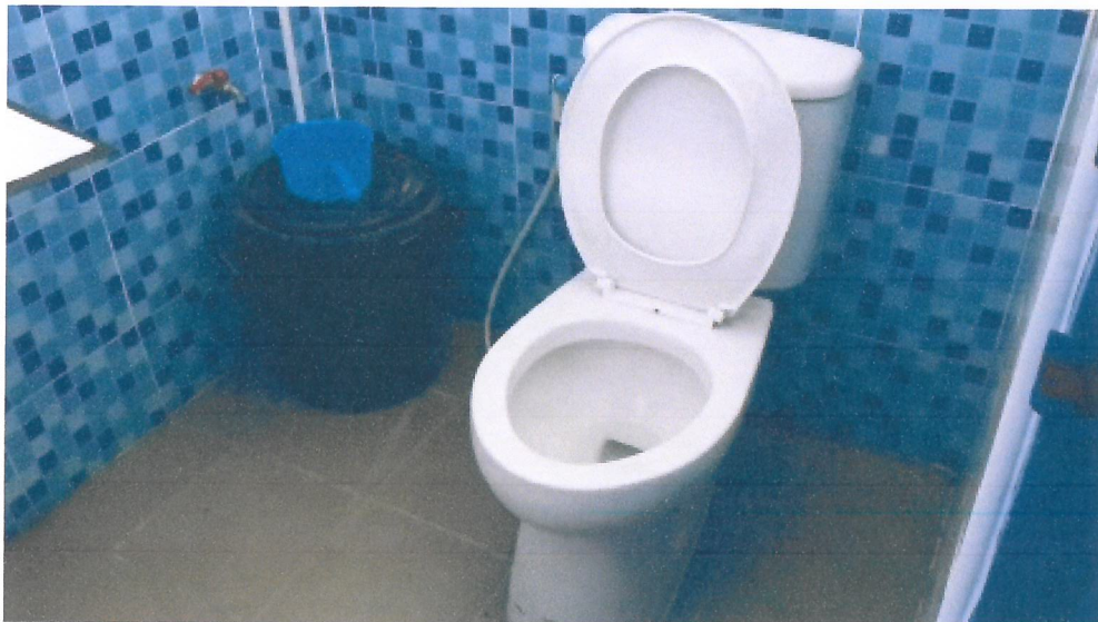
ปรับปรุงห้องน้ำครุ ชานพักบันไดชั้น 2-4 อาคาร 5 รวม 3 ชั้น จำนวน 6 ห้อง
