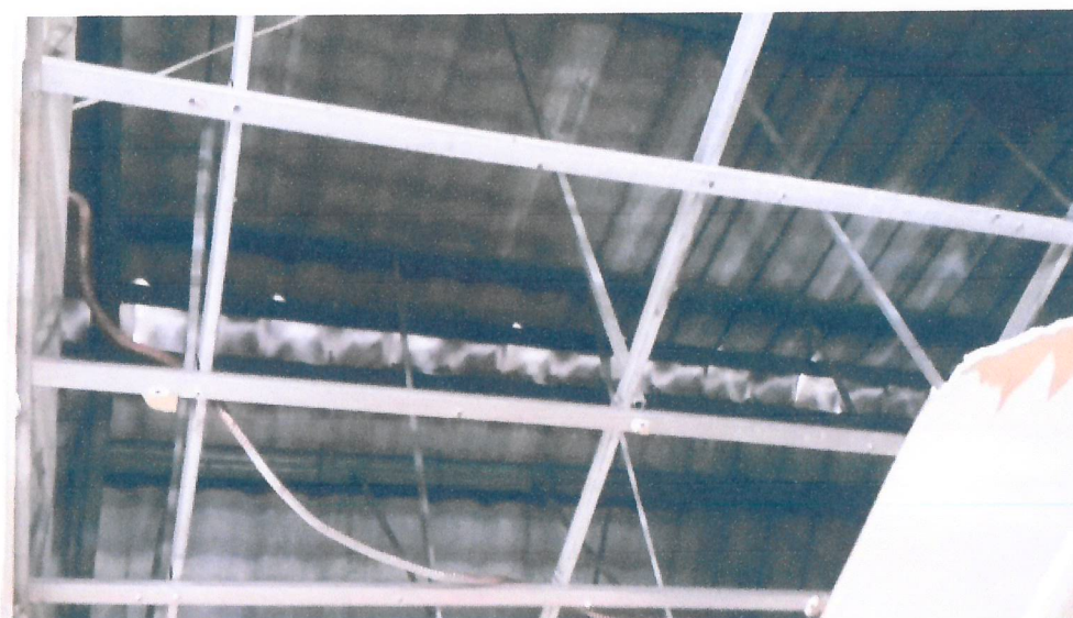
ปรับปรุงหลังคาอาคาร 3 จำนวน 1 แห่ง
