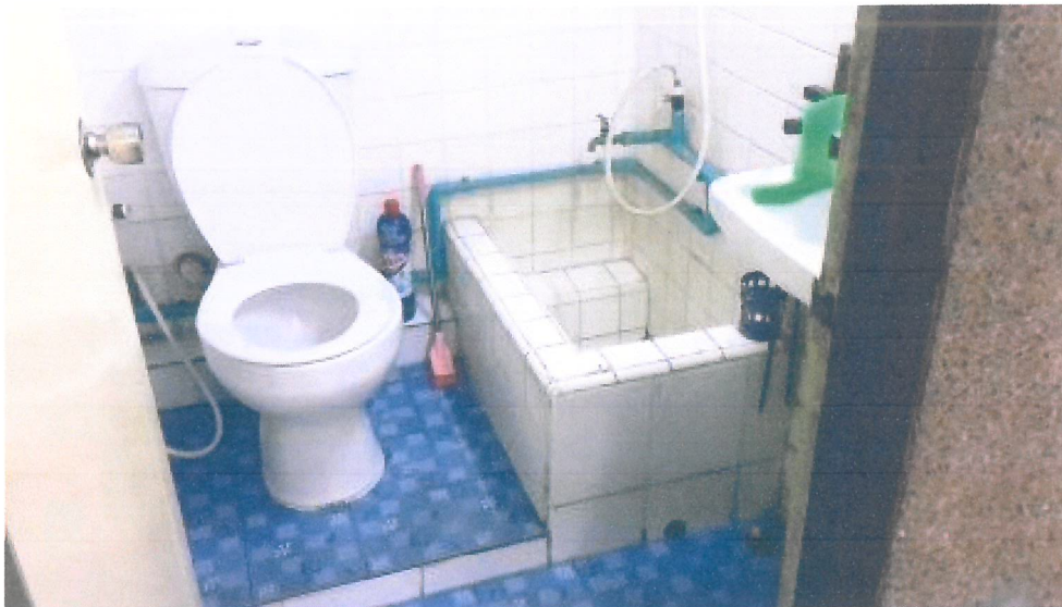
ปรับปรุงห้องน้ำครู ชั้น 1 อาคาร 2 จำนวน 2 ห้อง
