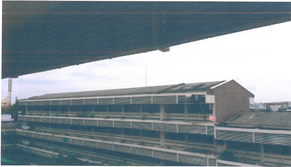
ปรับปรุงหลังคาอาคาร 2 จำนวน 1 แห่ง
