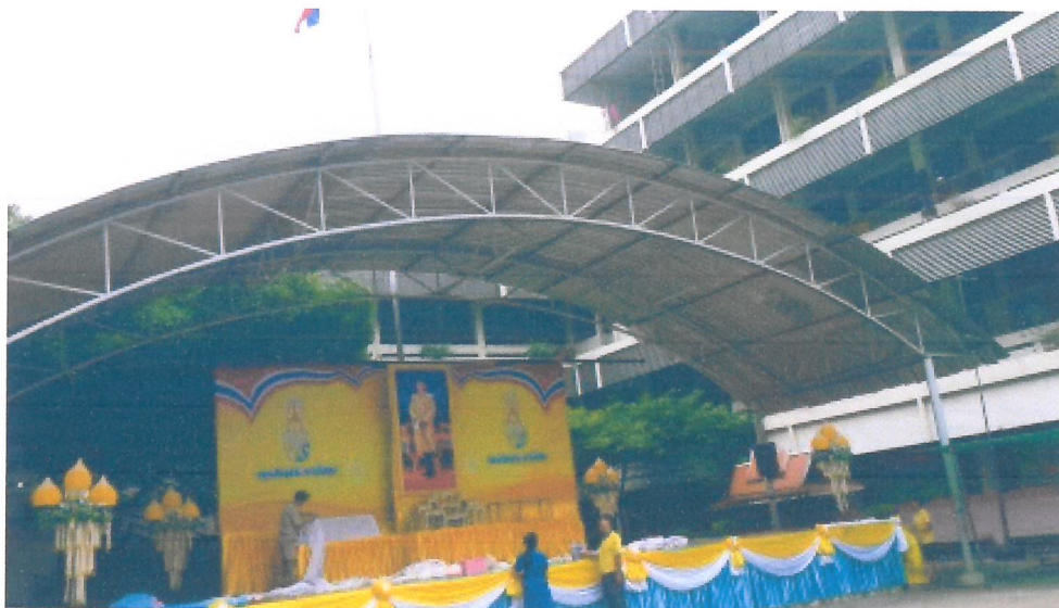
ปรับปรุงหลังคาโครงเหล็กเวที จำนวน 1 แห่ง
