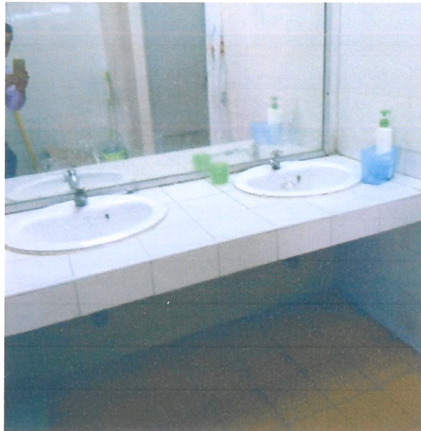
ปรับปรุงห้องน้ำ ชั้น 1-2 อาคาร 4 รวม 2 ห้อง
