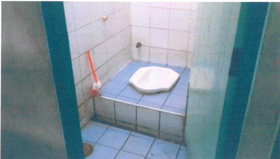
ก่อสร้างห้องนํ้านักเรียน จำนวน 1 หลัง
